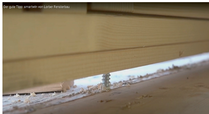
Professionell ist die mechanische Befestigung VOR dem Stopfen
