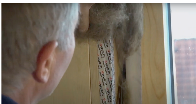
Fenstereinbau mit Stopfmaterial
