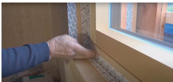
Wind- und Dampf dichte Verklebung
